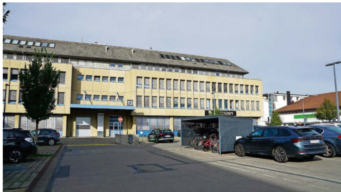
Dieses Haus wird zum Wohnhaus. Die bestehende Bausubstanz wird dafür genutzt.
